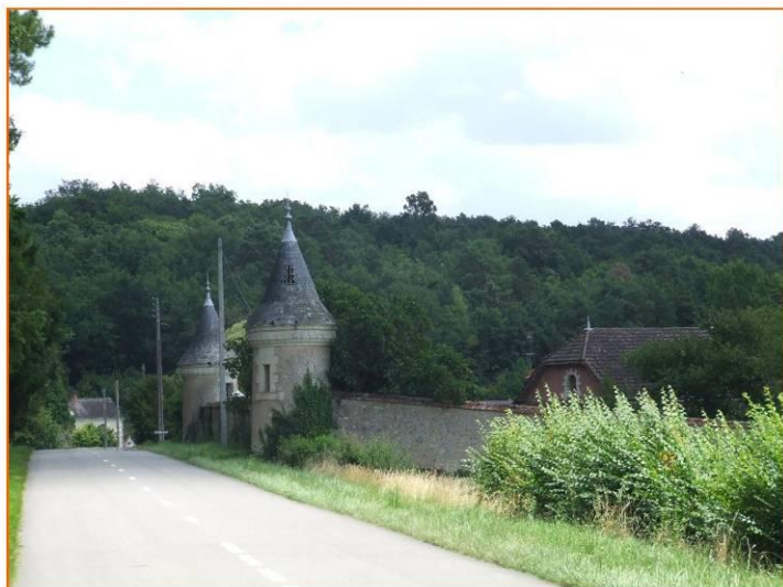
11. Mur d'enceinte du Moulin de Ris
